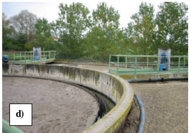
Figura 3.5.2. Problemi di bulking: a) impianto di Foligno – Colfiorito; b) impianto di Spoleto–Camposalese; c) impianto di Sigillo; d) impianto di Gubbio – S.Erasmo.
