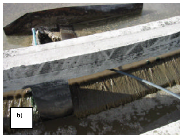
Figura 3.5.2. Eccesso di carico idraulico: a) impianto di Foligno – Casone; b) impianto di Spoleto – Camposalese.
