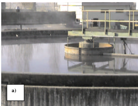
Figura 3.5.2. Eccesso di carico idraulico: a) impianto di Foligno – Casone; b) impianto di Spoleto – Camposalese.
